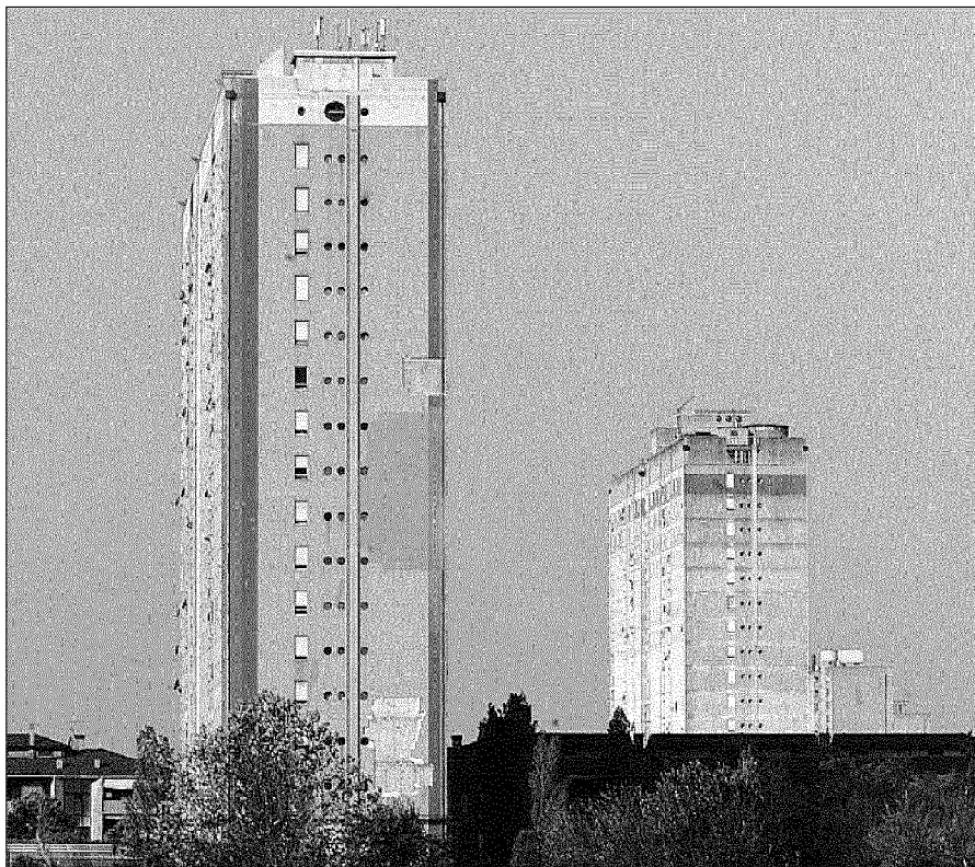
In primo piano la Cimabue, sullo sfondo la Tintoretto: le due torri di San Polo verranno abbattute
